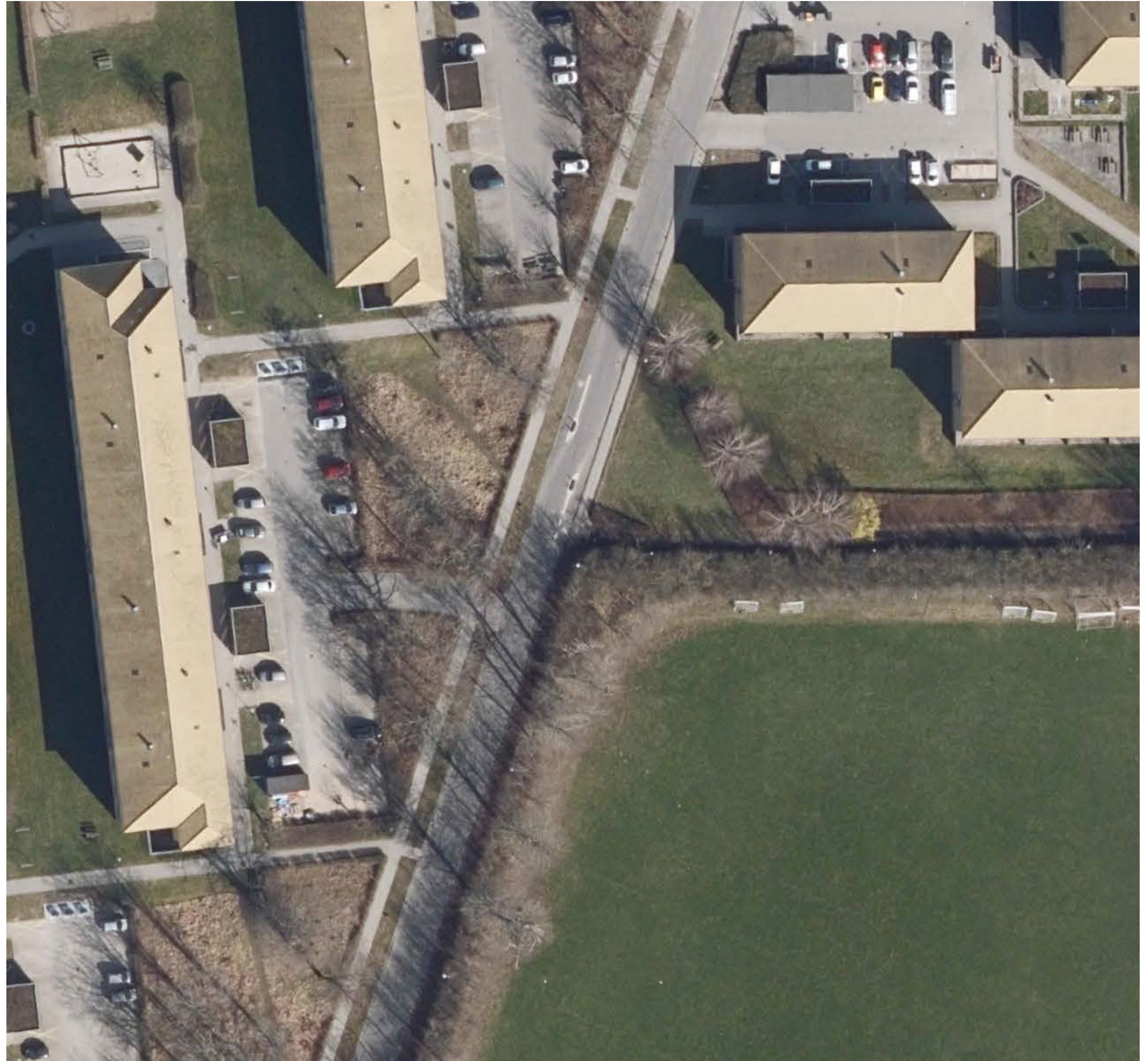
Luftfoto eksisterende forhold - den lille plads
